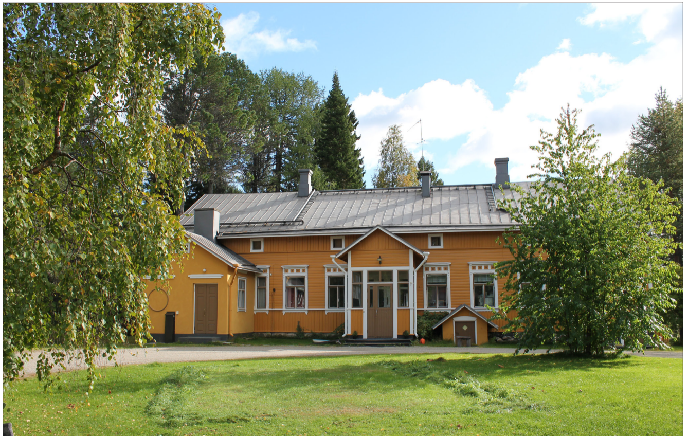
Hankkeessa kunnostetaan ja korjataan hirsirakenteinen 1800-luvulla rakennettu pappila yhteisöjen taloksi perinteitä kunnioittaen. Kuva: Raija Heikkinen
